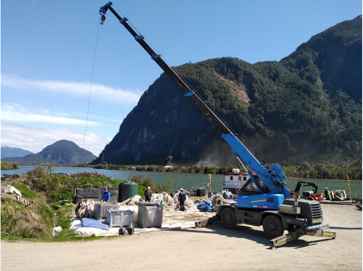
Ilustración 4: Trabajo con grúas en región de Aysén
